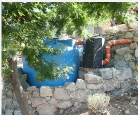
3.14 (Cisterna prima della muratura)
